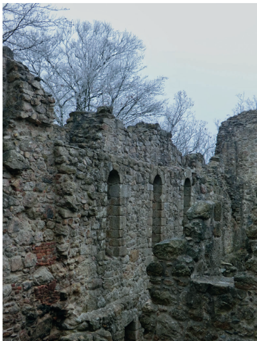
Bei der Burgruine Stockenfels im Regental lassen sich verschiedene Bauphasen ablesen. Funde aus verschiedenen Jahrhunderten der Nutzung sind im Boden erhalten. Foto: Christoph Steinmann, BLfD
